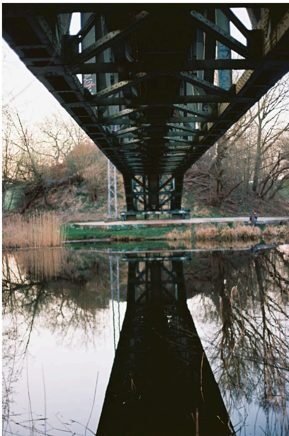
11 Stahl über Wasser Rostock, 2025
